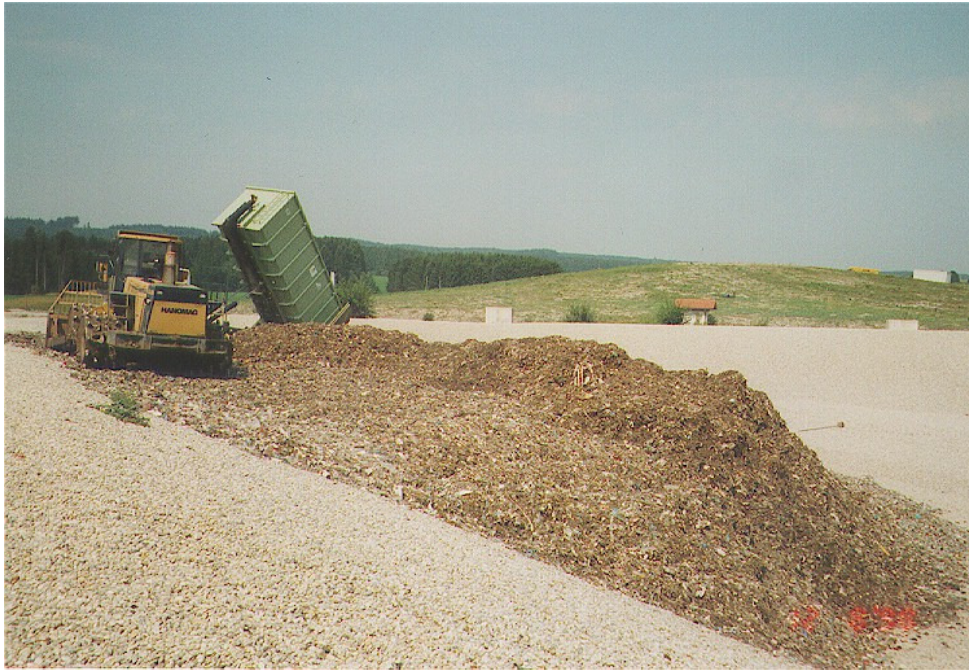
Abbildung 28: Einbau von Restabfallkompost mit Kompaktor
