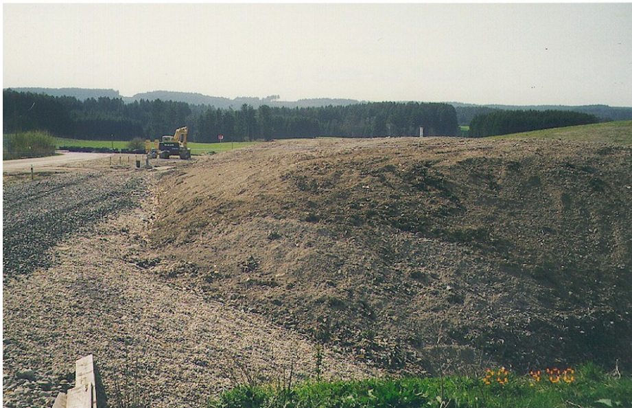
Abbildung 31: Verfüllter Deponieabschnitt mit Rekultivierungsschicht
