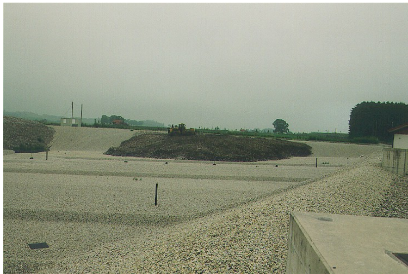
Abbildung 29: Einbaufeld von MBA-Abfalldeponat
