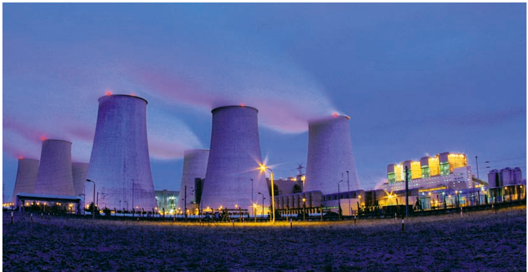
Eine Anlage, die vom EU-Emissionshandel betroffen ist: das Kohlekraftwerk Jämschwalde Foto: © Andreas F., Photocase.de
